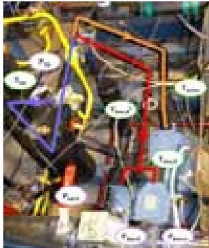
Figura 2. 26. Conexión corriente de inyección directa de líquido y ubicación de sensores en el compresor
